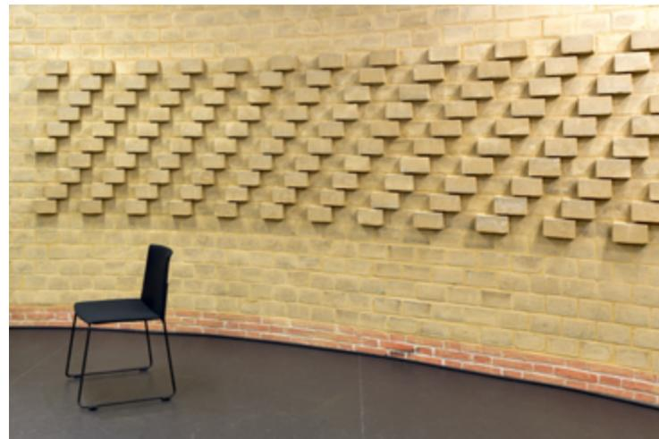
Dans l'auditorium, la pose en relief des briques de terre crue compressée formant le mur porteur produit un double effet, décoratif et acoustique.
